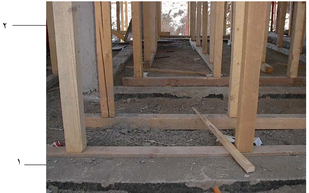
شكل رقم ( ٢٤ ) يبين استخدام العروق الفليري كفرشات أسفل القوائم الرأسية بالدور الأرضي
