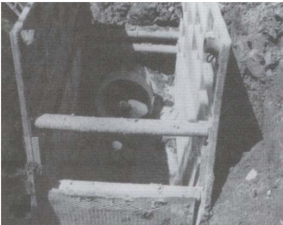
شكل (٩.٤): مراحل تنفيذ مواسير التصريف.
