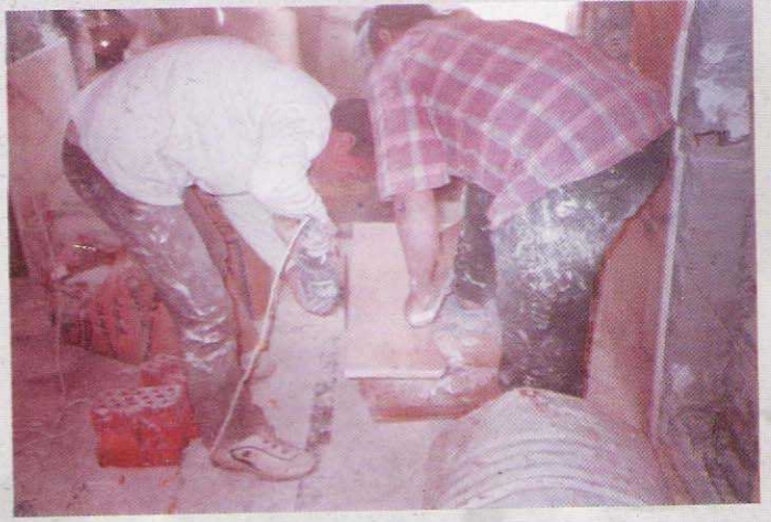
• عملية تقطيع الرخام بالصاروخ.
