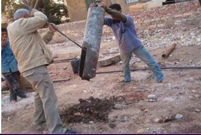
14- استخدام البلف للحصول على العينات حتى العمق المطلوب
