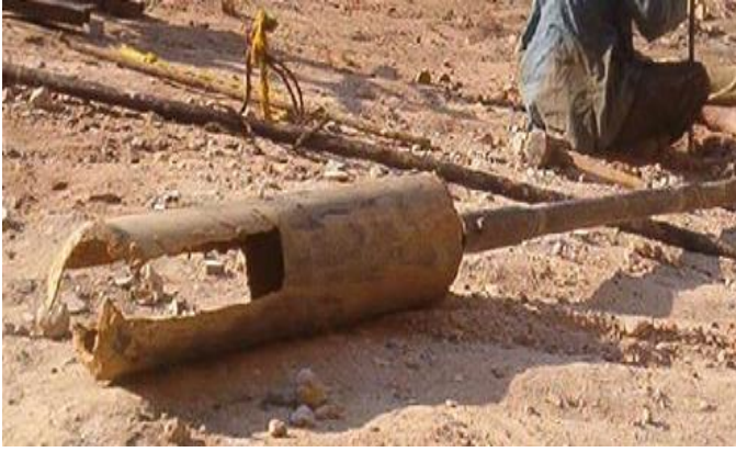
8- عمل حفرة مكان الجسه حتى يسهل على البريمه اختراق التربه فى المكان المحدد
