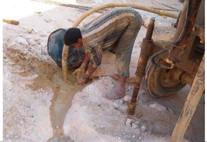
7- ربط فدية القطع في ماسورة الكور لأستخدامها في الحفرة واخذ العينات التي تدخل للكور
