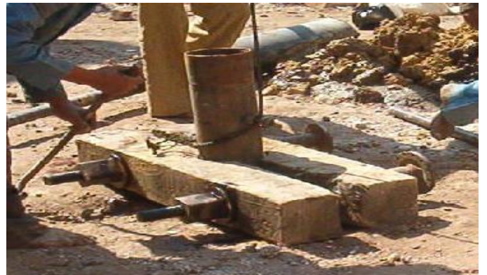
9- لمنع تهيب التربه اثناء الحفر يتم وضع مواسير السند وتثبيتها بالزرجينه
