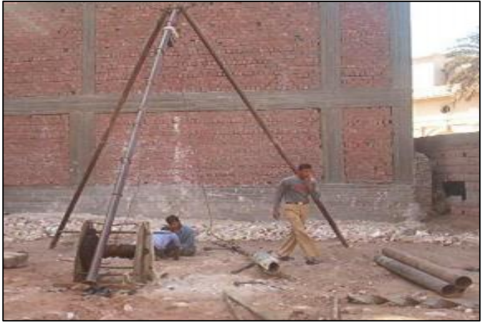
9- لمنع تهيب التربه اثناء الحفر يتم وضع مواسير السند وتثبيتها بالزرجينه
