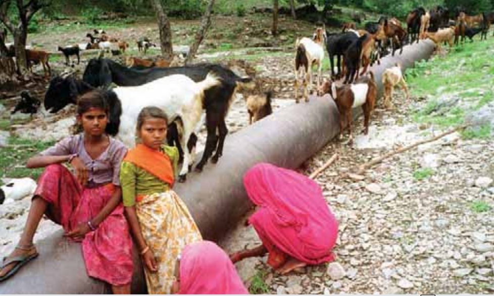
الهند، ولاية راجستان. يؤمن هذا الأنبوب الذي يخرج من بحيرة جايساموند، المياه لسكان أودايبور.
