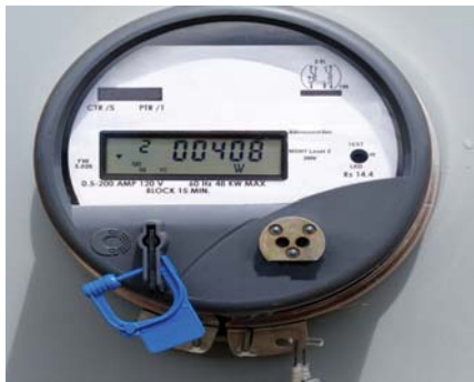
■ شكل (٥) العداد الرقمي لاستهلاك الكهرباء أحد العناصر الأساسية لشبكات الكهرباء الذكية.
