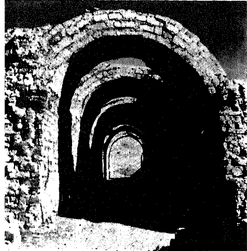
أحد المخازن بمعبد الرمسوم .. وتظهر موازريك الطوب في الوضع الطولي والأفقي
