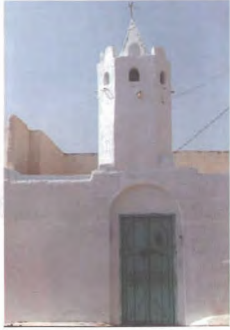
الصورة (١٤٢) مئذنة مسجد الشريف وواجهته
