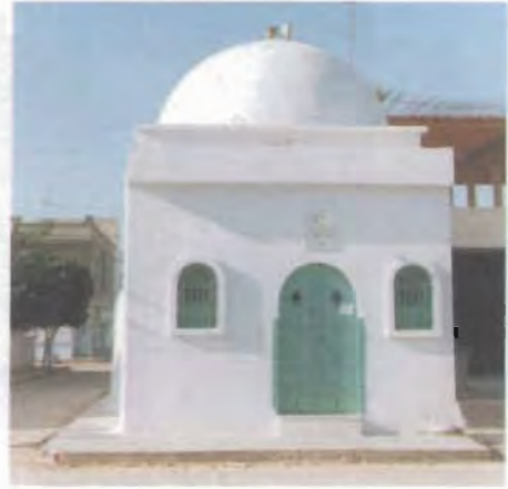
الصورة (١٢٢) الواجهة الشرقية بمسجد البرهان
