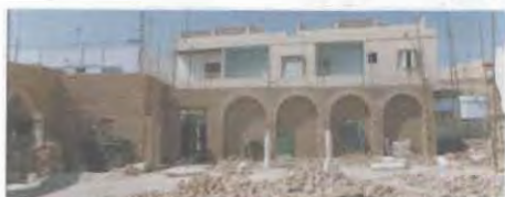
الصورة (٧١) الرواق الغربي بجامع الزيتونة
