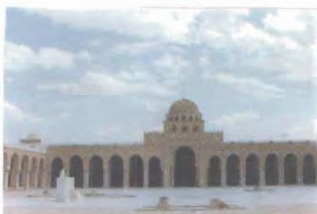
الصورة (٢٥) واجهة الرواق الجنوبي
