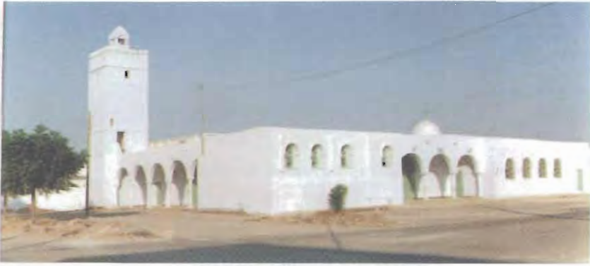
الصورة (١٠١) مئذنة جامع حي المنصورة وواجهاته
