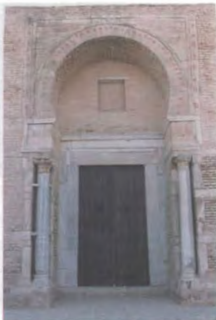
الصورة (٤٢) الباب الأول في الواجهة الشرقية بدءاً من الشمال
