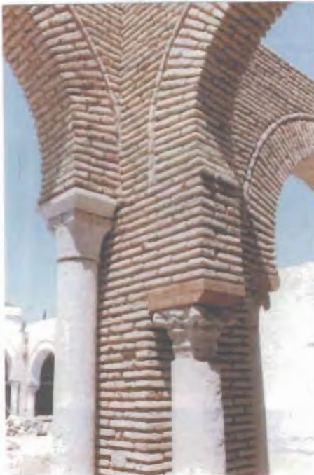
الصورة (٦٨) تفصيل في أقواس الرواق الجنوبي بجامع الزيتونة
