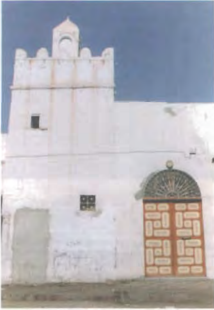
الصورة (١٠٥) المئذنة القديمة والواجهة الغربية بجامع الحمامي
