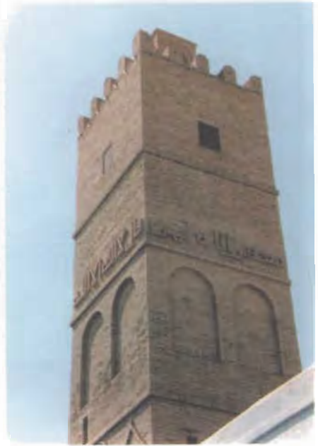
الصورة (١٣٦) مئذنة المسجد المعلق (الواجهتان الشمالية والشرقية)
