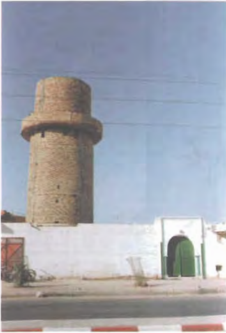
الصورة (١٤٣) مئذنة مسجد الفتح (مفتاح) وواجهته
