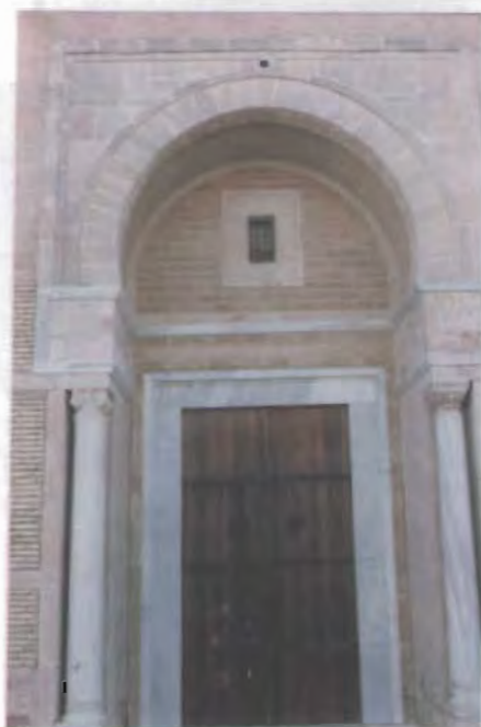
الصورة (٤٣) الباب الثاني بالواجهة الشرقية
