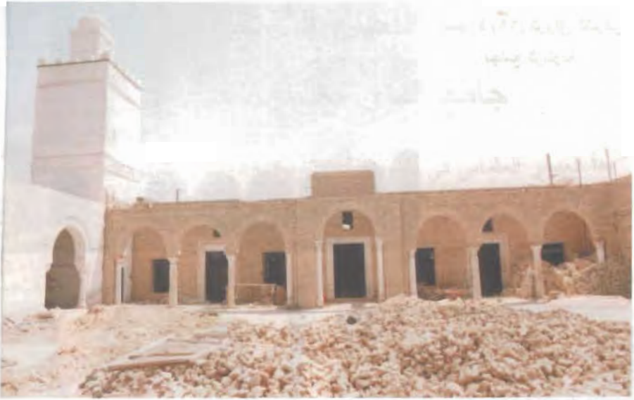
الصورة (٦٦) واجهة الرواق الجنوبي بجامع الزيتونة
