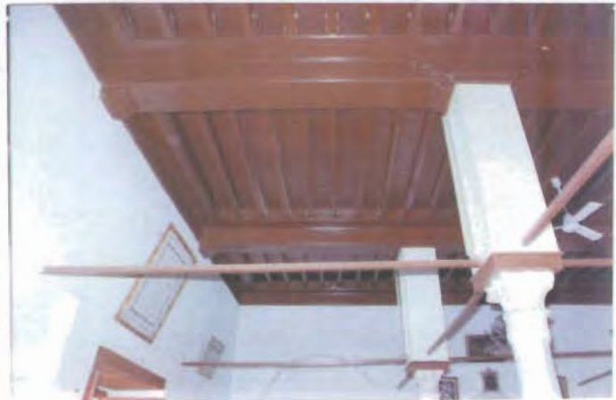
الصورة (١٢٥) سقف المسجد المعلق
