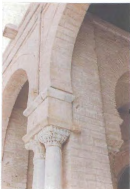
الصورة (٢٦) تفصيل بواجهة الرواق الجنوبي
