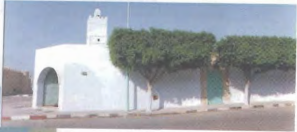
الصورة (١١٠) الواجهة الخارجية الغربية بجامع نقرة
