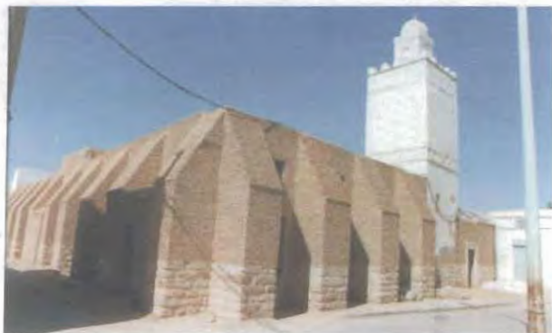
الصورة (٧٢) الواجهة الخارجية الشرقية لجامع الزيتونة
