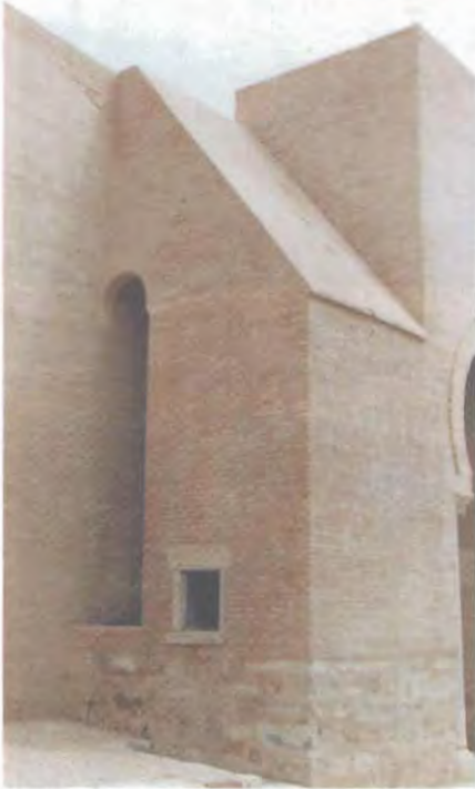
الصورة (٤٩) دعامة بالواجهة الغربية
