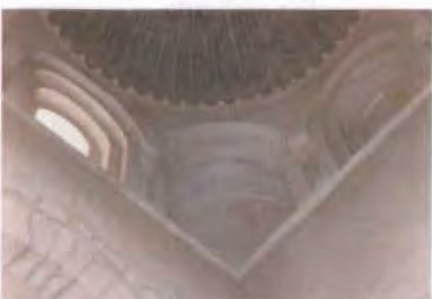
الصورة (٤٦) قبة برج باب ريحانة من الداخل
