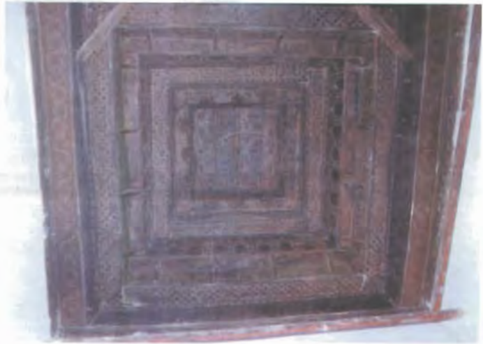
الصورة (١١٧) سقف غرفة الضريح بمسجد الداروني
