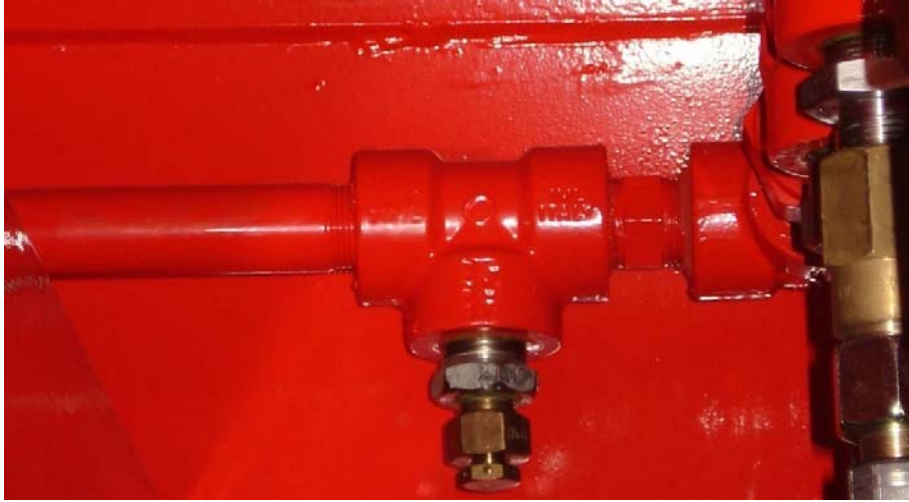
حماية خط التفريغ الرئيسي وشبكة الأنابيب باستخدام قرص انفجاري
