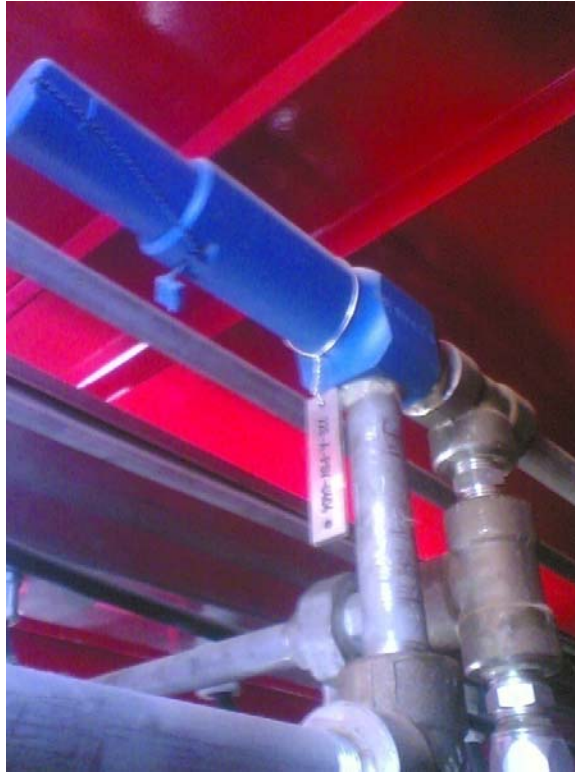
حماية خط التفريغ الرئيسي وشبكة الأنابيب باستخدام قرص انفجاري
