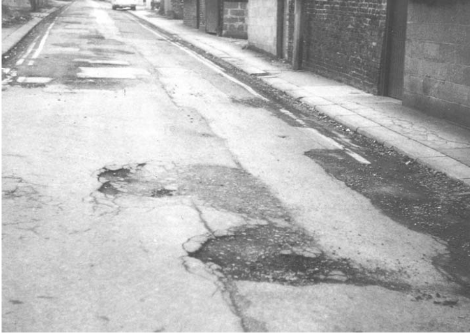
(ج) انهيار الرصف
