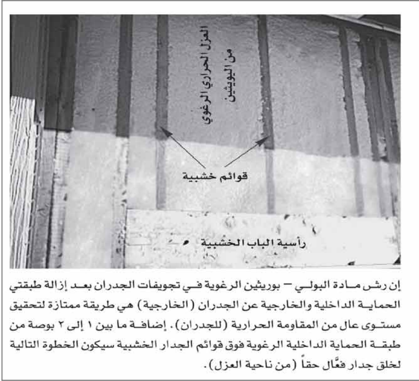
شكل رقم (٧-٤) العزل الحراري المنفذ بالرش والمصنوع من البولي-يوريثين
