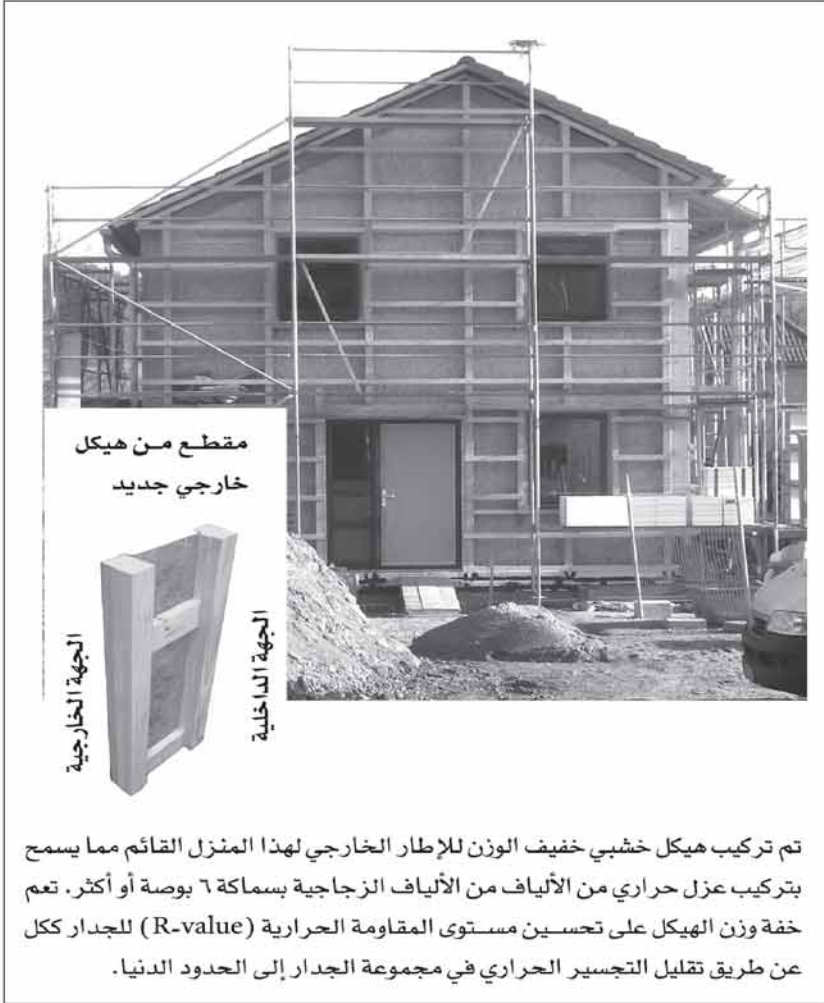
شكل رقم (٧-١٥) تركيب هيكل خارجي خفيف الوزن
