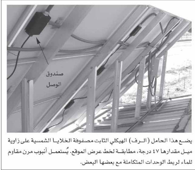
شكل رقم (١١-١٠) رف هيكلي ثابت لتركيب الخلايا الشمسية
