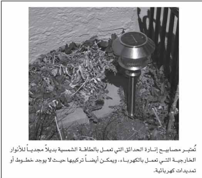
شكل رقم (٢-٥) إنارة خارجية للفناء تعمل بالطاقة الشمسية
