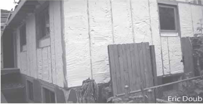
الجدار المضاف الجديد بعد ملئه بعزل حراري من الأيسيتين الرغوي
