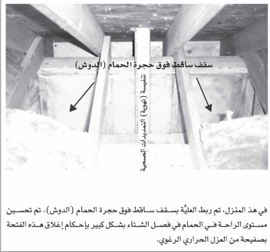
شكل رقم (٦-١٠) إغلاق التجاويف فوق الأسقف البارزة الساقطة
