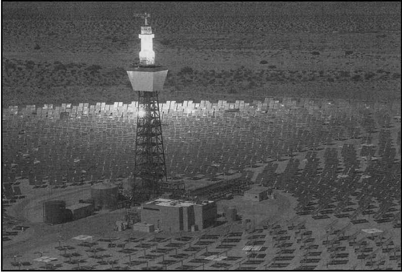
الشكل (7-1): منشأة الطاقة الشمسية التركيبية Solar two
