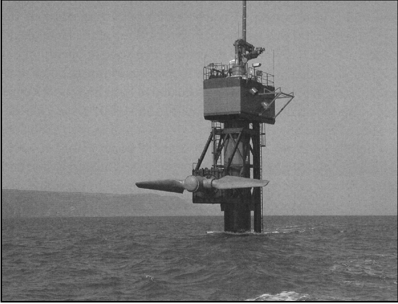
الشكل (7-7): مولد تيار مد وجزر 300 كيلو واط نوع "Seaflo".
