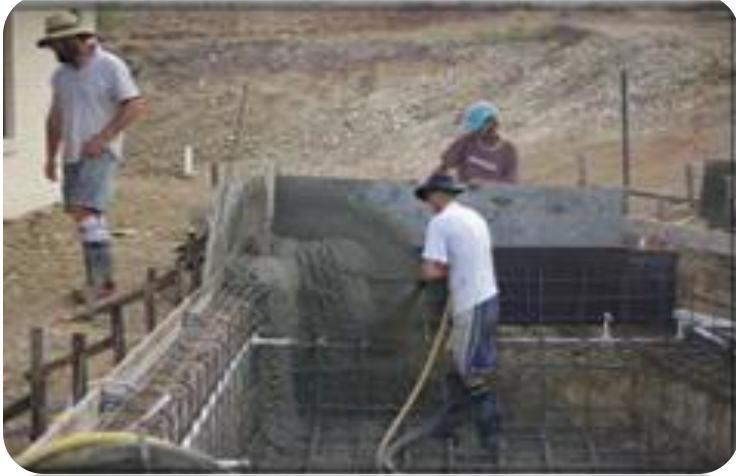
صورة اثناء صب الخرسانه
