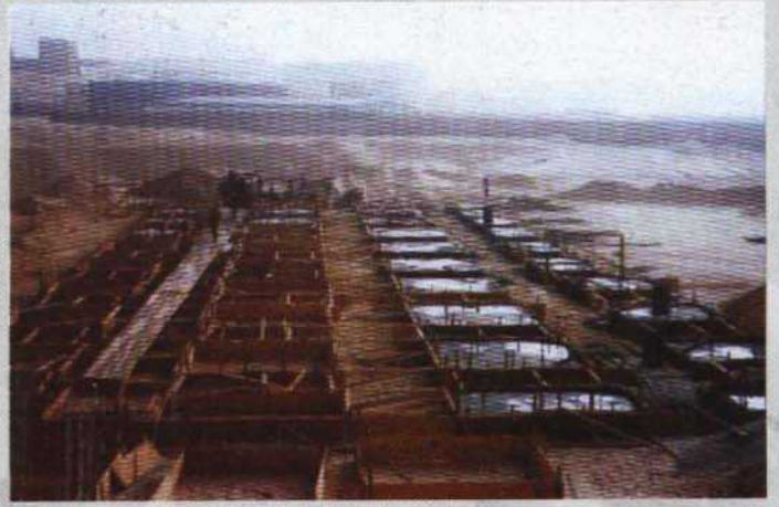
• تنظيم طريقة الصب للخرسانة العادية
