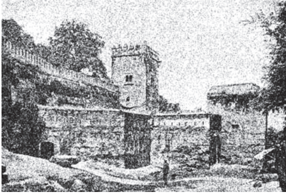
القصبة أو قلعة الحمراء وهي أقدم بناء لبنى الأحمر في غرناطة.
