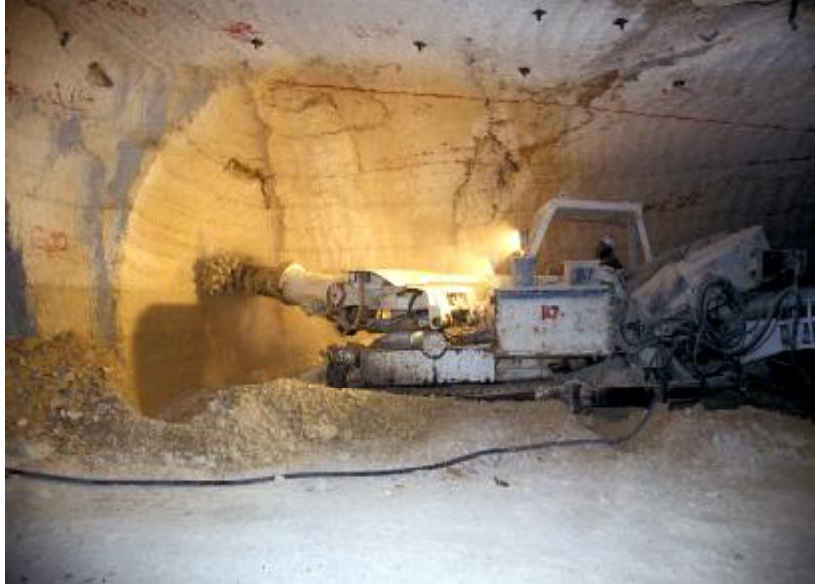
الشكل (٤) أعمال الحفر بواسطة معدة الحفر الميكانيكية ((Road Header
