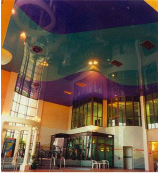
الصورة توضح السقف المطاطي المعلق فوق الفراغ
