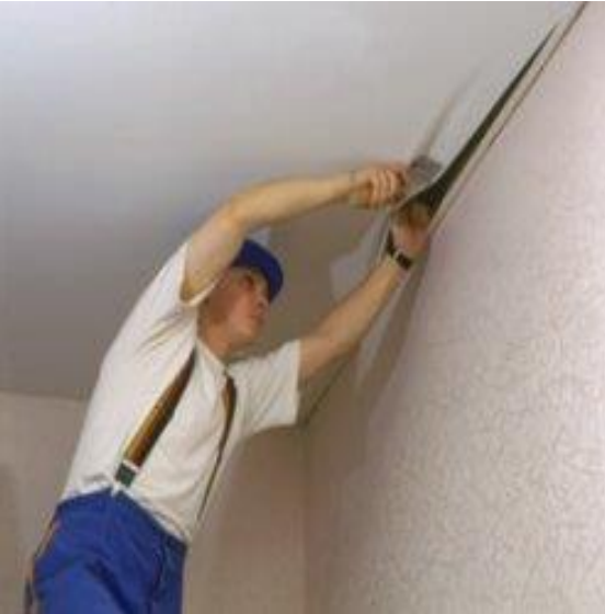
تثبيت الحلية البلاستيكية فى الحائط وتثبيت طرف السقف بها
