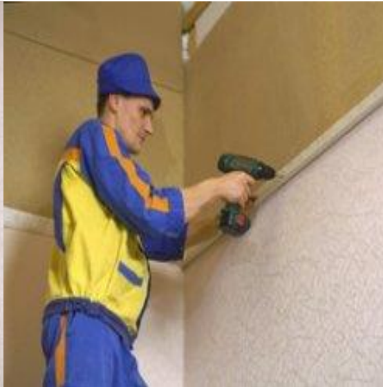
تثبيت الحلية البلاستيكية فى الحائط وتثبيت طرف السقف بها
