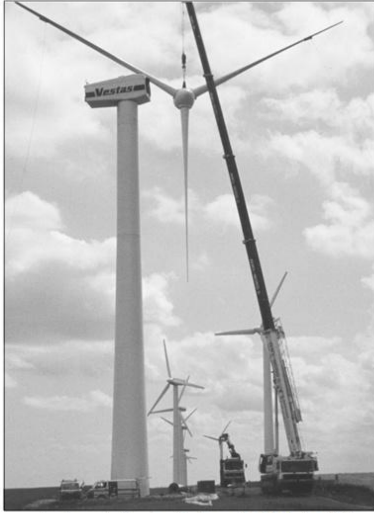
الشكل رقم (٢٥) : تجميع الريش على الارض ورفعها
