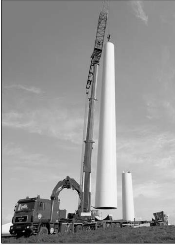
الشكل رقم (٢٦) : رفع البرج لتركيبه على القاعدة
