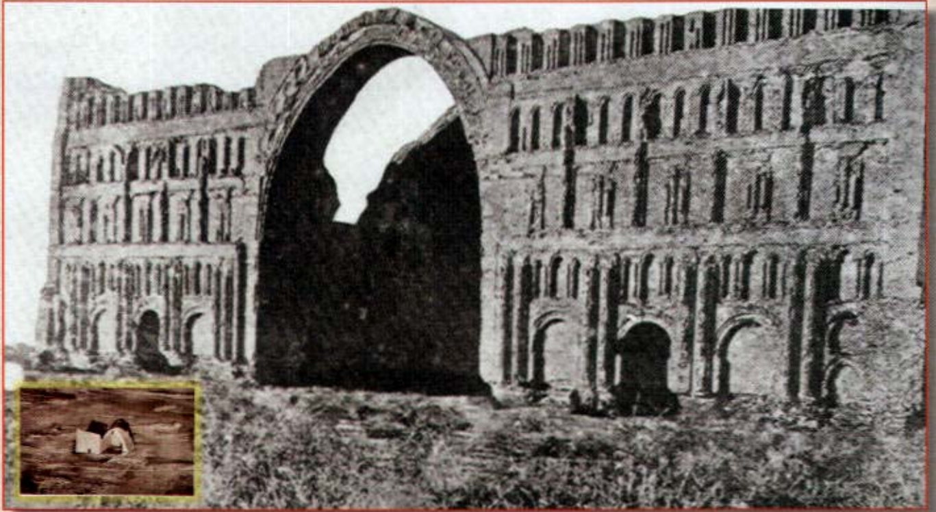
واجهة إيوان كسرى قبل سقوط الجناح الأيمن من واجهة القصر وكان انهيار هذا الجناح في ١٥ نيسان ١٨٨٨م عند فيضان نهر دجلة - م . الصورة، شريف منصور .
