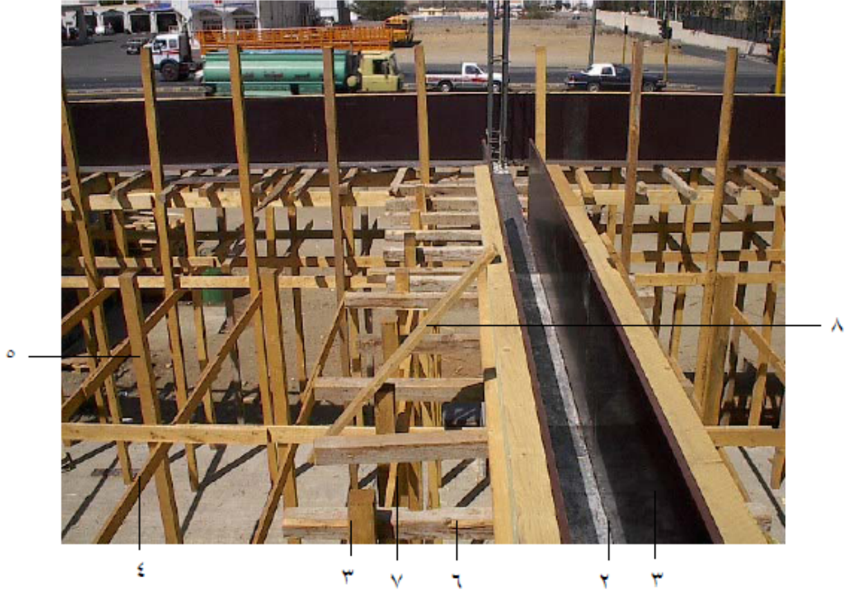
شكل رقم ( ٤٢ ) أعمال التخشيب للكمرة
