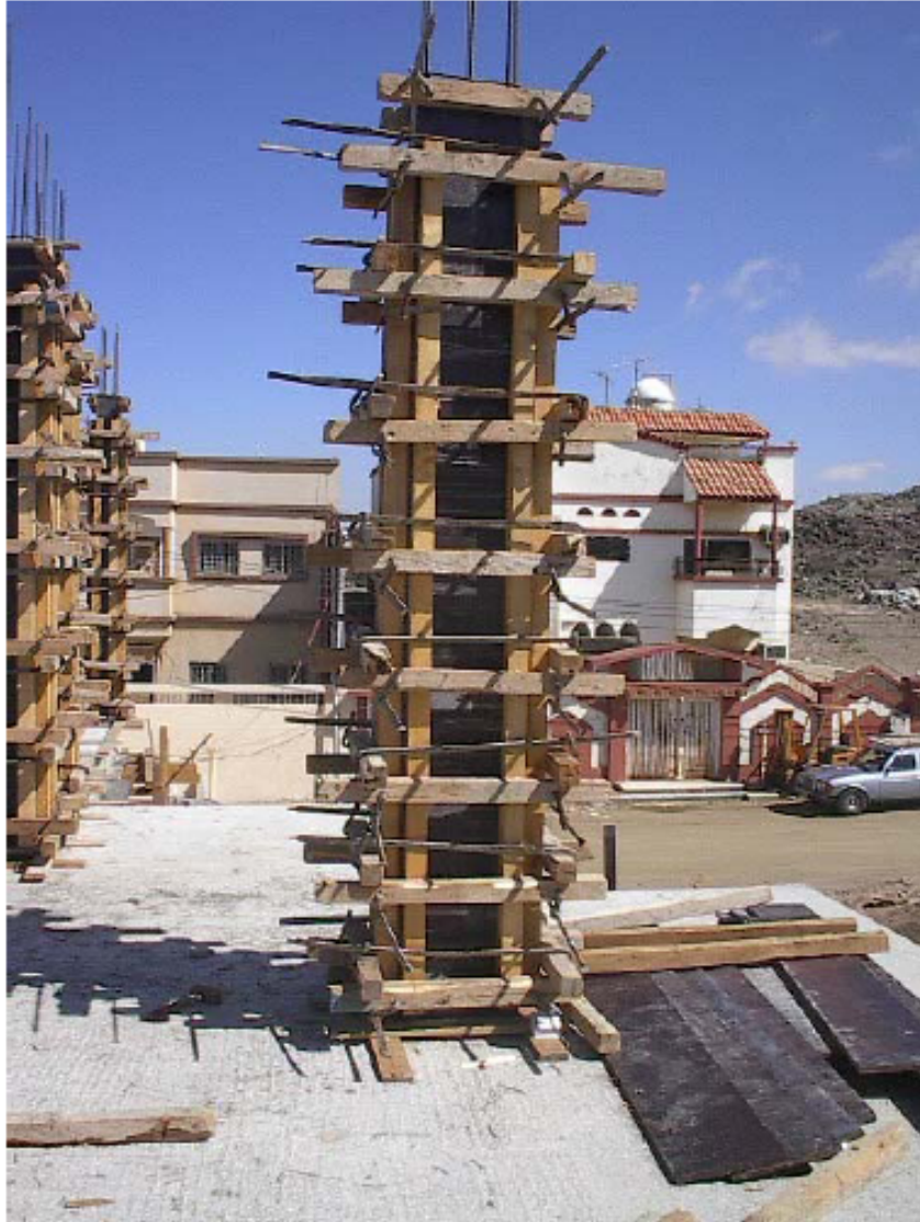
شكل رقم (٥٢) يبين تحزيم العمود باستخدام مرايبع وقصاير المرايبع الفلييري مع ضفدعة العمود باستخدام القمط الحديدية بدلا من ألواح الموسكي (تثبيت العمود رأسيا تأتي بعد الانتهاء من التقوية)
