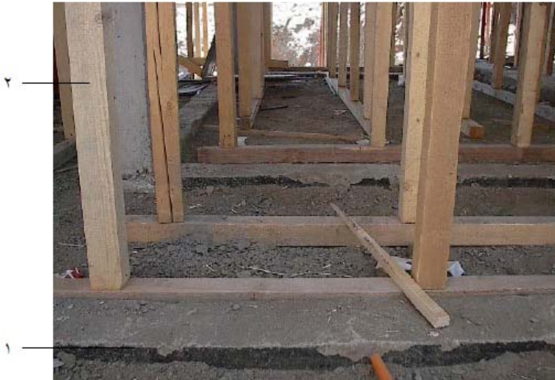
شكل رقم (٢٤) يبين استخدام العروق الفلييري كفرشات أسفل القوائم الرأسية بالدور الأرضي
