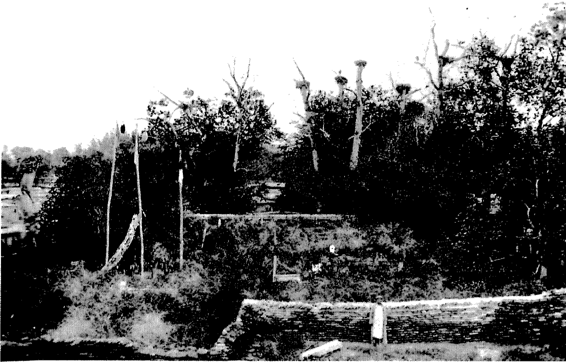
111 مجمع مباني أعظم الحكام. منظر عام لضريح الولي مقدام الاقدام. تصوير: بانكراتييف ١٨٩٤
