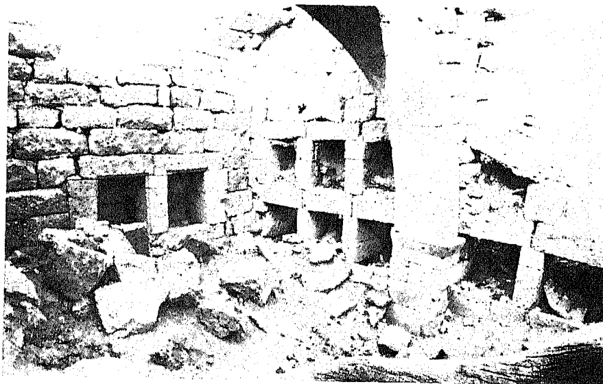
(ب) المسيفرة - البيت رقم ١ - الزاوية الشمالية الشرقية للفرقة الرئيسية في الطابق الأسفل
