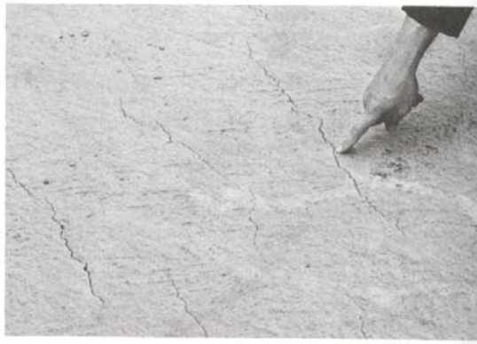
شكل رقم ٩,٤: تشققات اللدنة.
