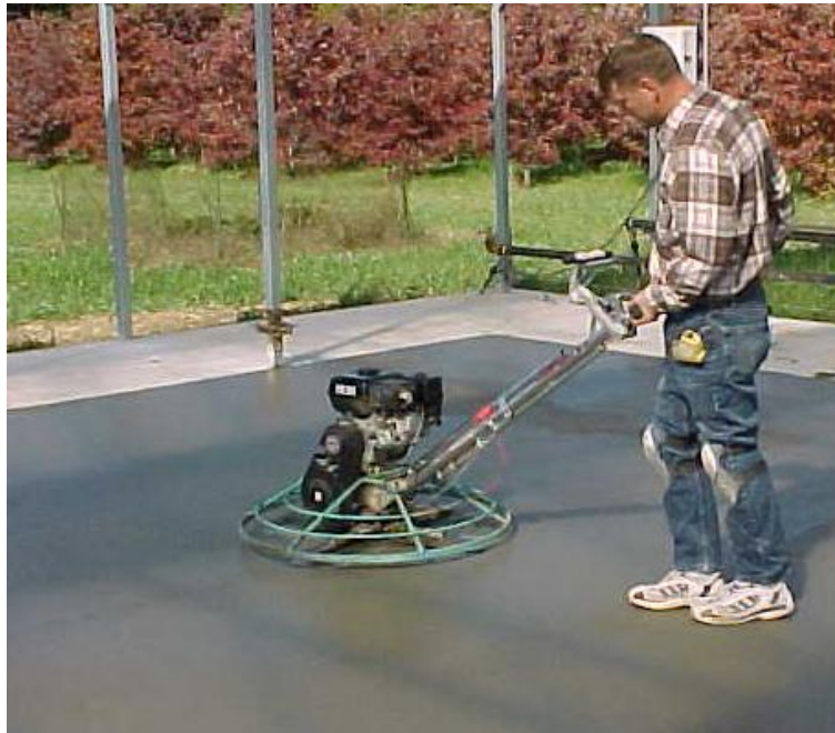
شكل رقم ١٧.١: تهذيب سطح الخرسانة ميكانيكيا باستعمال آلة التهذيب.
