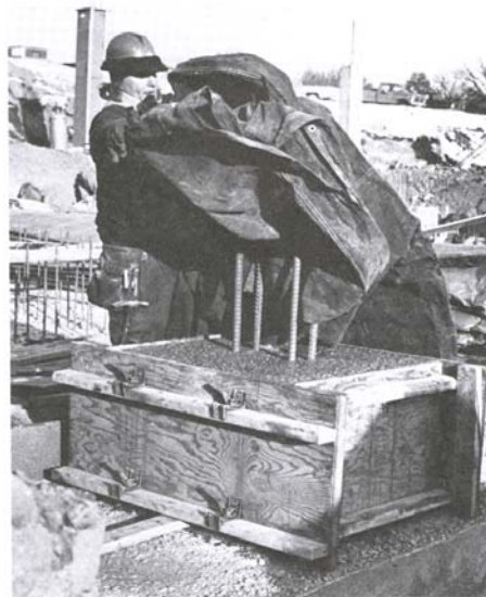
شكل رقم ٣,٥ : تغطية سطح الخرسانة بمادة عازلة للاحتفاظ بالحرارة داخل الخرسانة
