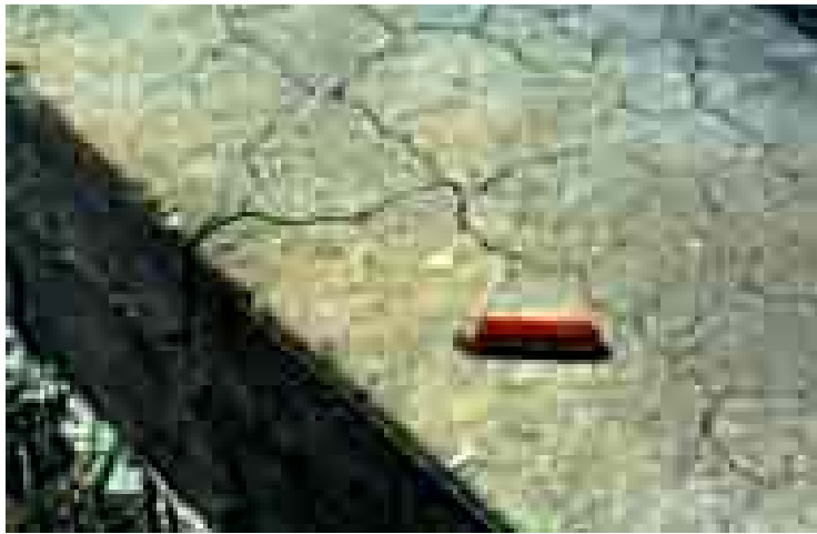
شكل رقم ٧,٣: تشققات في الخرسانة نتيجة ارتفاع كبير للحرارة خلال معالجتها بالبخار.
