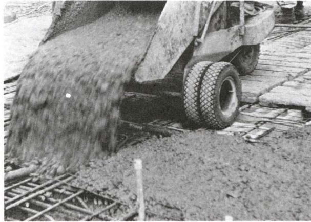
شكل رقم ٥,١: صب الخرسانة من أقرب مكان (العربة)
