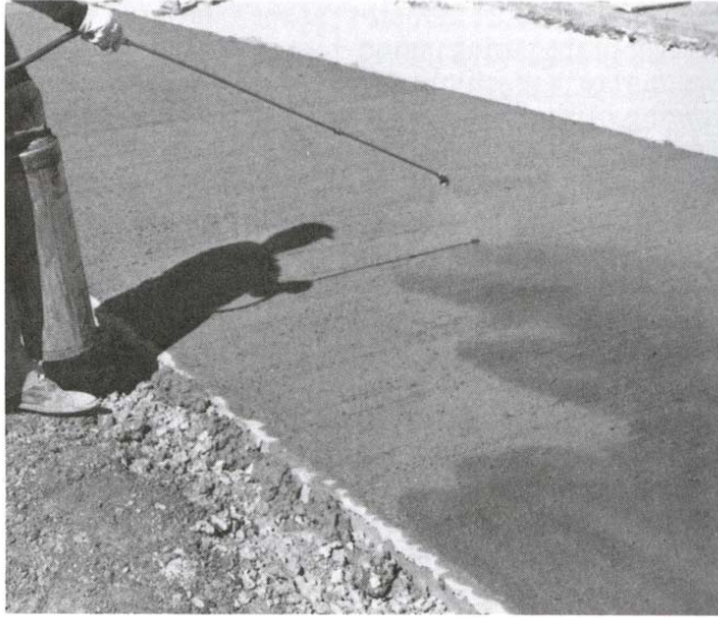
شكل رقم ٨.٢: معالجة الخرسانة بواسطة نثر المركبات الكيميائية لمنع تبخر الماء من سطح الخرسانة.
