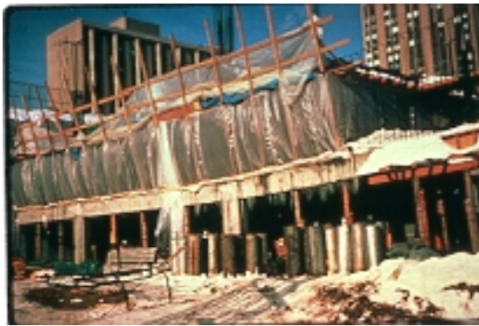
شكل رقم ٢,٥ : استعمال الألواح البلاستيكية لمعالجة الخرسانة في المناطق الباردة
