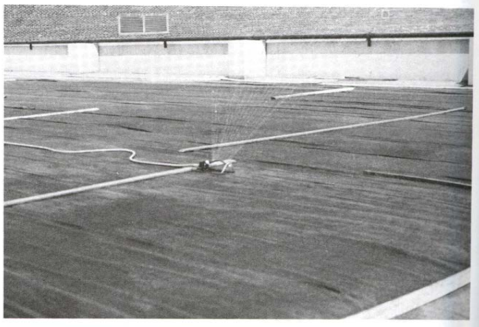
شكل رقم ٥,٢: معالجة الخرسانة بأغشية مبللة بالماء.
