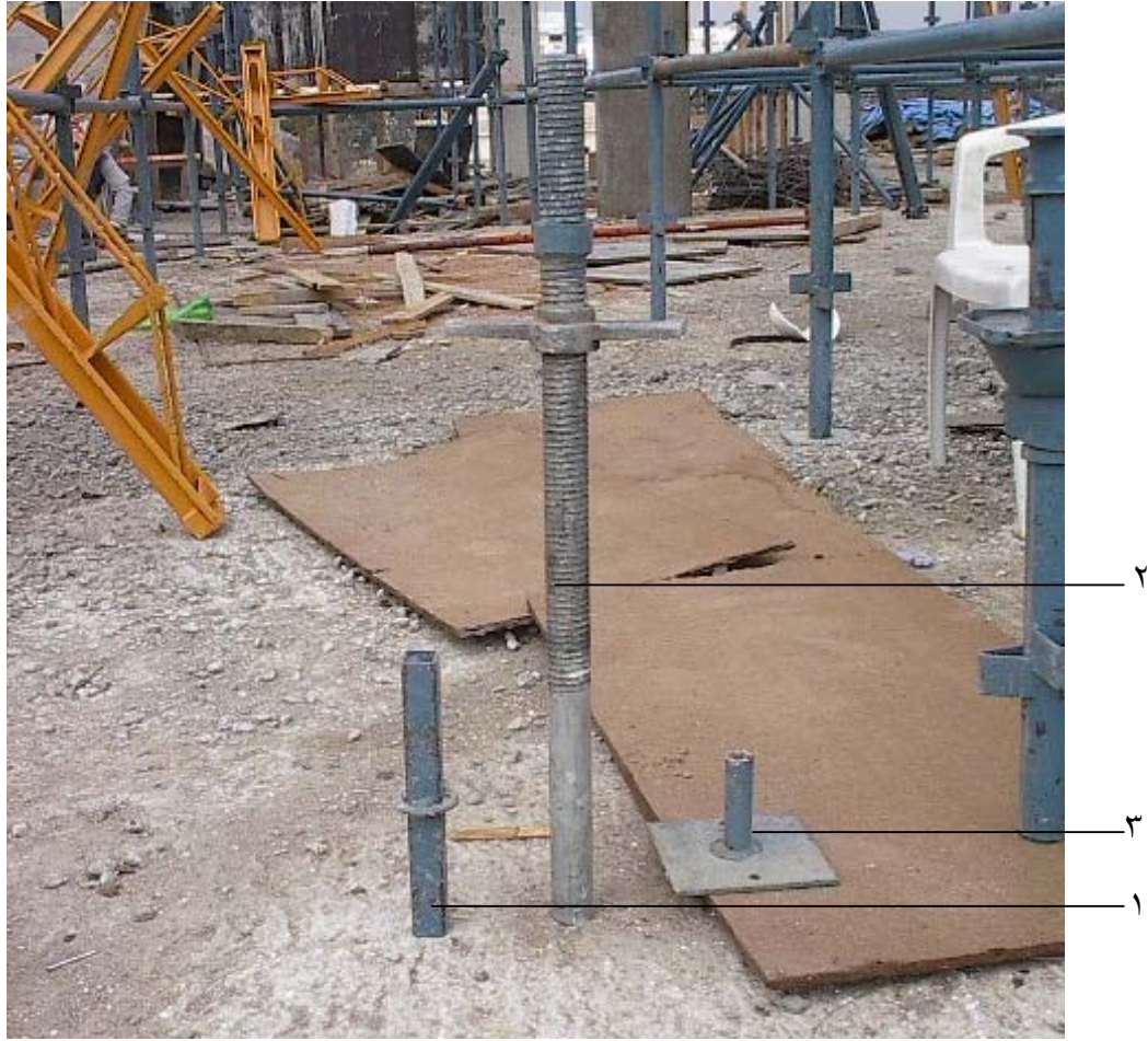
شكل رقم (٨٥) يبين بعض مكونات الشدة المعدنية
