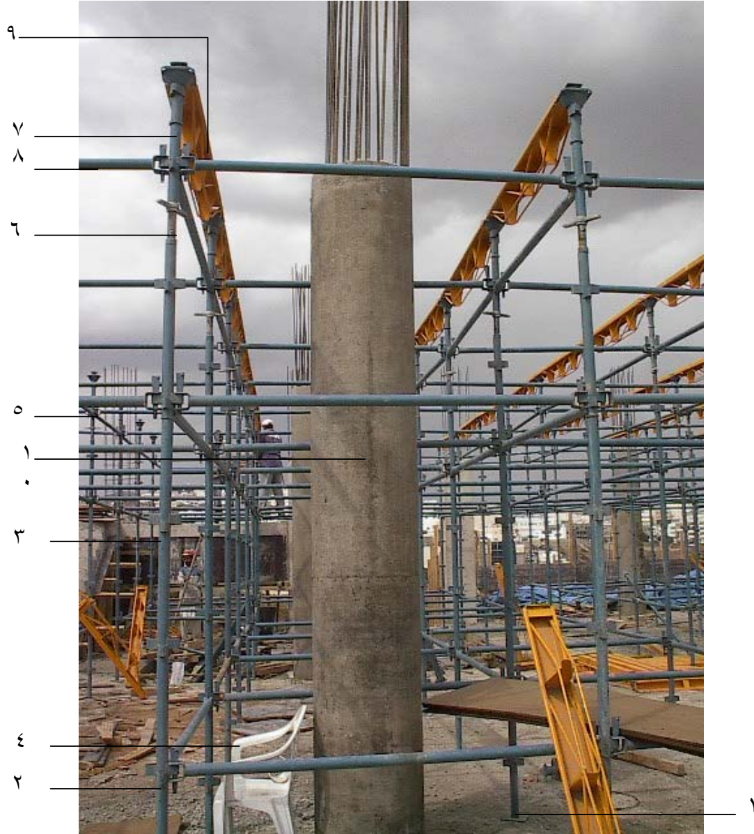
شكل رقم (١٠٢) مكونات تركيب الشدة المعدنية
