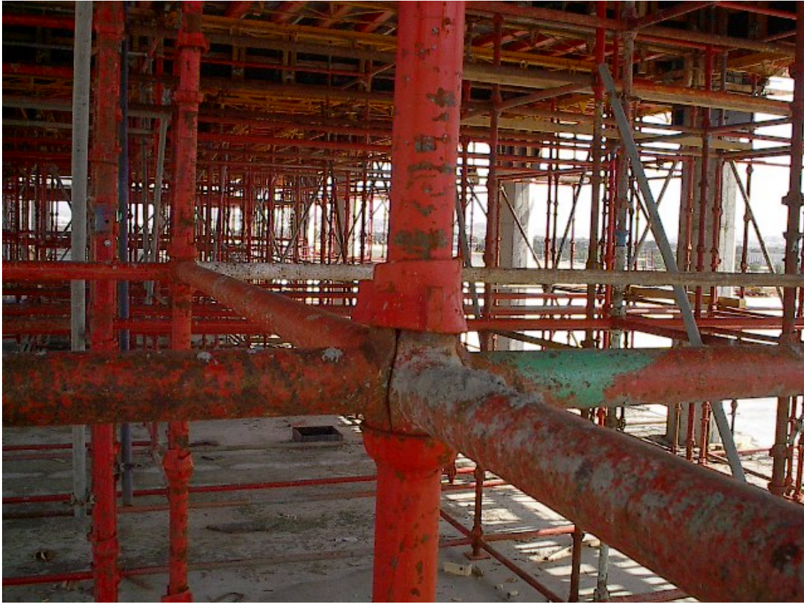
شكل رقم (٨٤) يبين نقاط تجميع العوارض الحديدية
