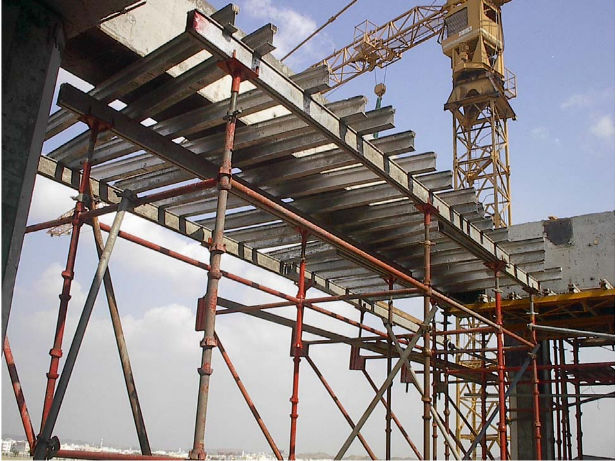
شكل رقم ( ٨٩ ) يبين استخدام العرقات والتطاريح من قطاعات الألمونيوم مع الشدة المعدنية
