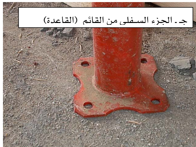
شكل رقم (٧٩) أجزاء الدعائم المعدنية
