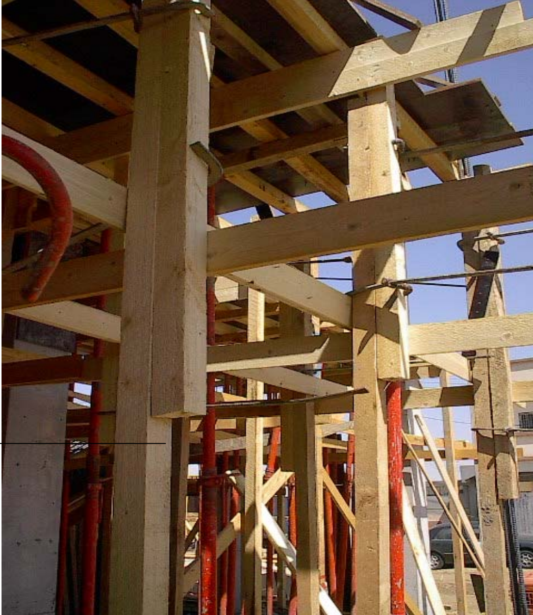
شكل رقم ( ٣١ ) استخدام القمط الحديدية في عمل ضفدعة (وصلات) رأسية لقوائم الأعمدة ١ - قمط حديدية ٢ - عروق ثم عمل وصلات رأسية لها (ضفدعة)
