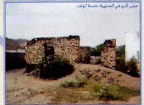
مبنى لذي في الحديبية، عمارة المرافق.
