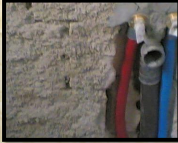
تركيب مواسير الكهرباء
