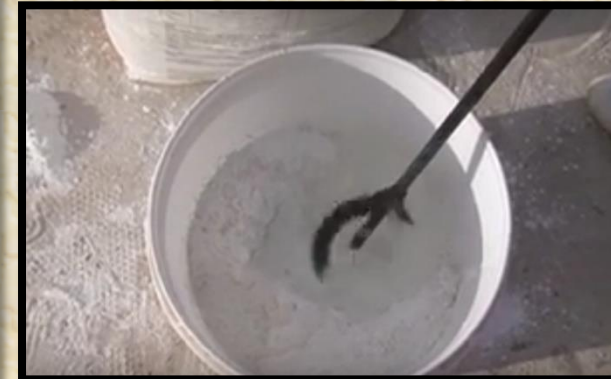
خلط الاسمنت بالماء
