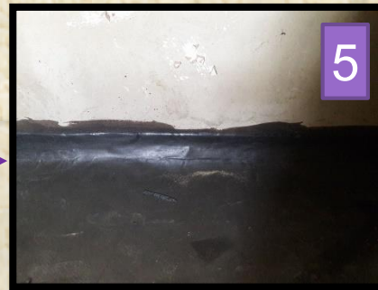
5- عمل رقبة الزجاجا من العزل لحماية السقف الخرسانى
