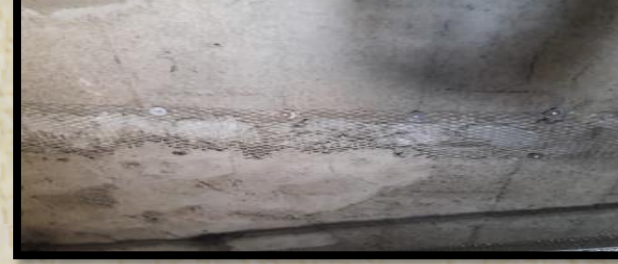
استخدام السلك لتغطية أسلاك الكهرباء
