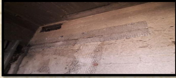
استخدام السلك للفصل بين انواع الماتريال المختلفه
