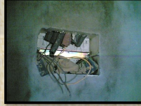
تركيب العلب الكهربائية
