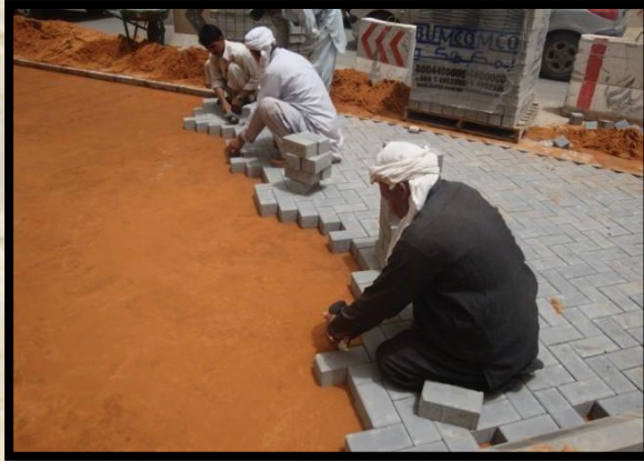
3- يتم تركيب ارضيات الانترلوك
