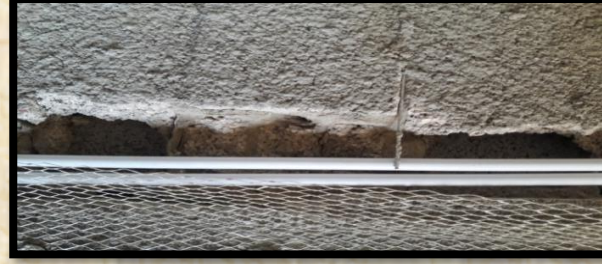
استخدام السلك لتغطية أسلاك الكهرباء
