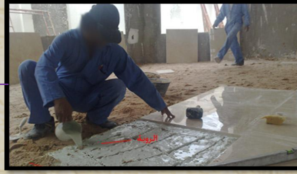
فرد المونه الاسمنتيه اسفل البلاطه بالكامل
