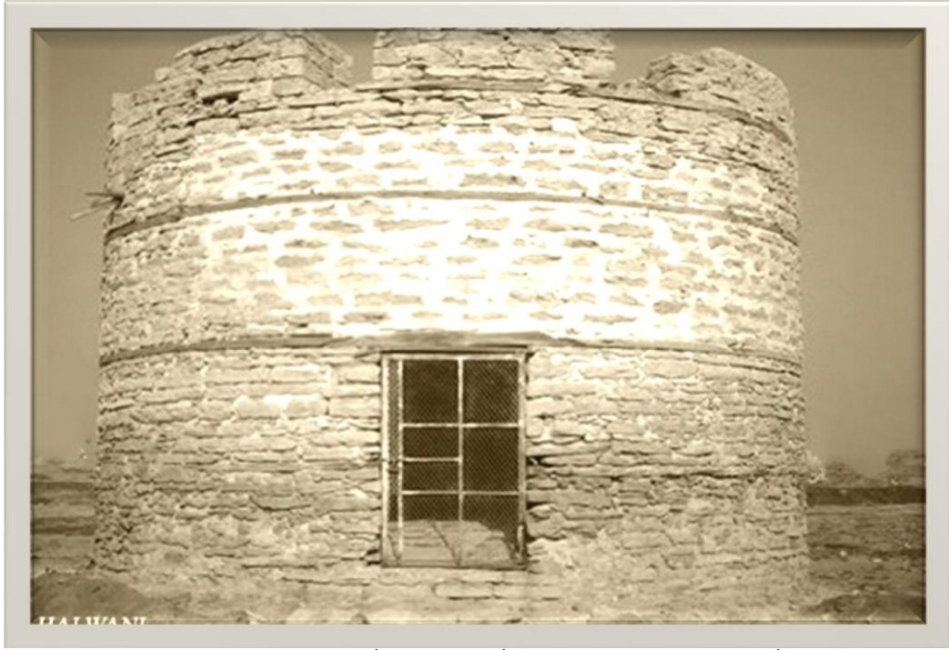
مبنى الطاحونة ويعرف أيضا باسم الكازخانة وهو من أقدم المباني الأثرية في القنفذة يقدر عمره الزمني بنحو ٢٠٠ سنة تقريبا
