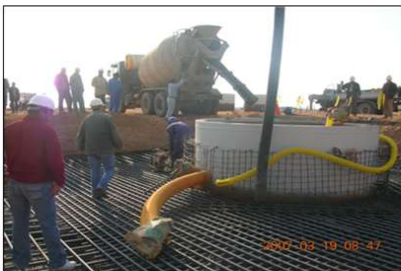
الشكل رقم (٢٥) : عملية تجهيز القاعدة الخرسانية
