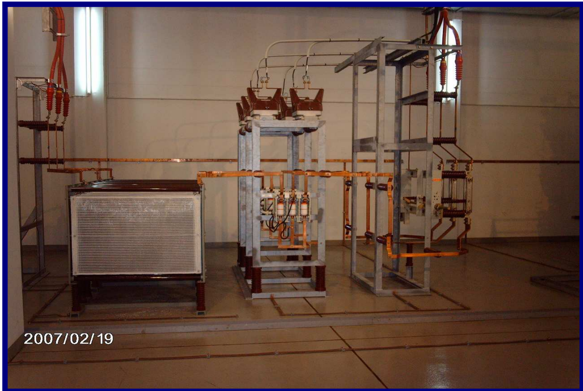
الصورة توضح المقاومة المستخدمة لعمل قصر بين مرشحي التوافقيتين الثانية والثالثة
