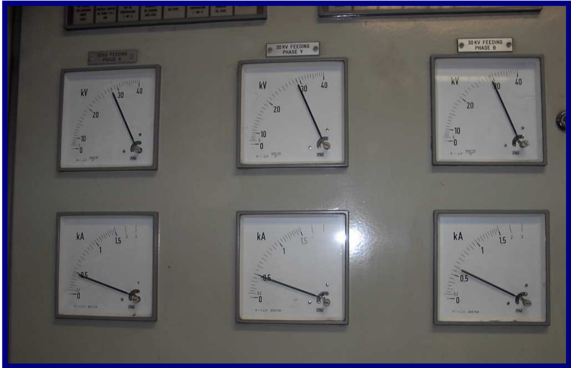
الصورة توضح قياس الجهد والتيار للملف الابتدائي لمحور الفرن
