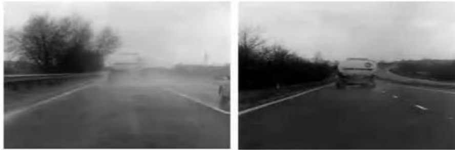
الشكل رقم (٤) المياه ترش بواسطة مركبة ثقيلة على طبقة الاسفلت العادية والتي يسهل اختراقها المرجع رقم (٢٠)
