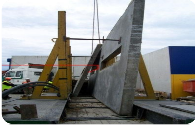
(مبنى متعدد الأدوار من البريكاست)
