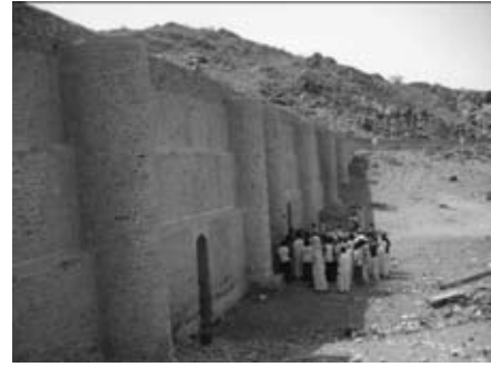
صورة رقم (٧) تظهر إحدى قنوات عين زبيدة الظاهرة على سطح الأرض والمعلقة فوق الجسور
