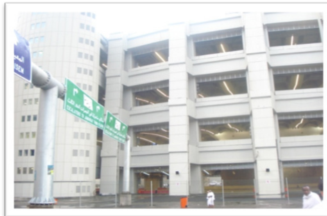
شکل (۴۷) ساختمان‌های احداث شده بر محل رمی جمرات سه گانه همراه با تابلوهای
