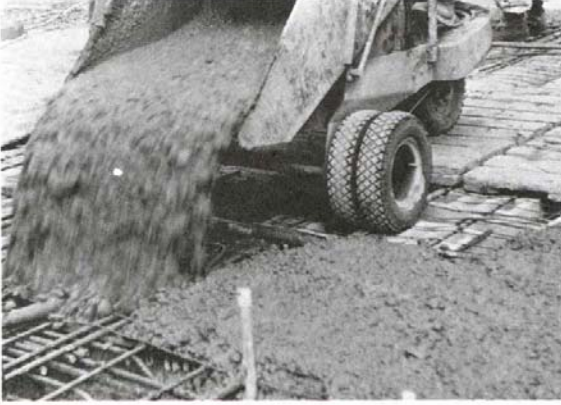
الشكل 16 : دمبر Dumper لنقل وصب
