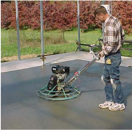
الشكل 22 : تهذيب سطح الخرسانة باستعمال آلة التهذيب
