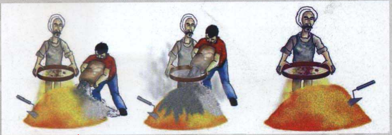
ضرورة هز الرمل قبل الاستعمال طريقة مرفوضة لأنه يزيد من هالك الأسمنت المتطاير طريقة مقبولة
